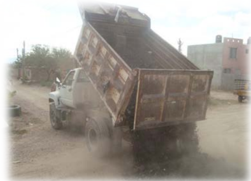
Rehabilitación de calle con material de gradero.
