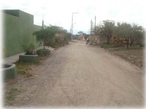
Rehabilitación de calle con material de gradero.
