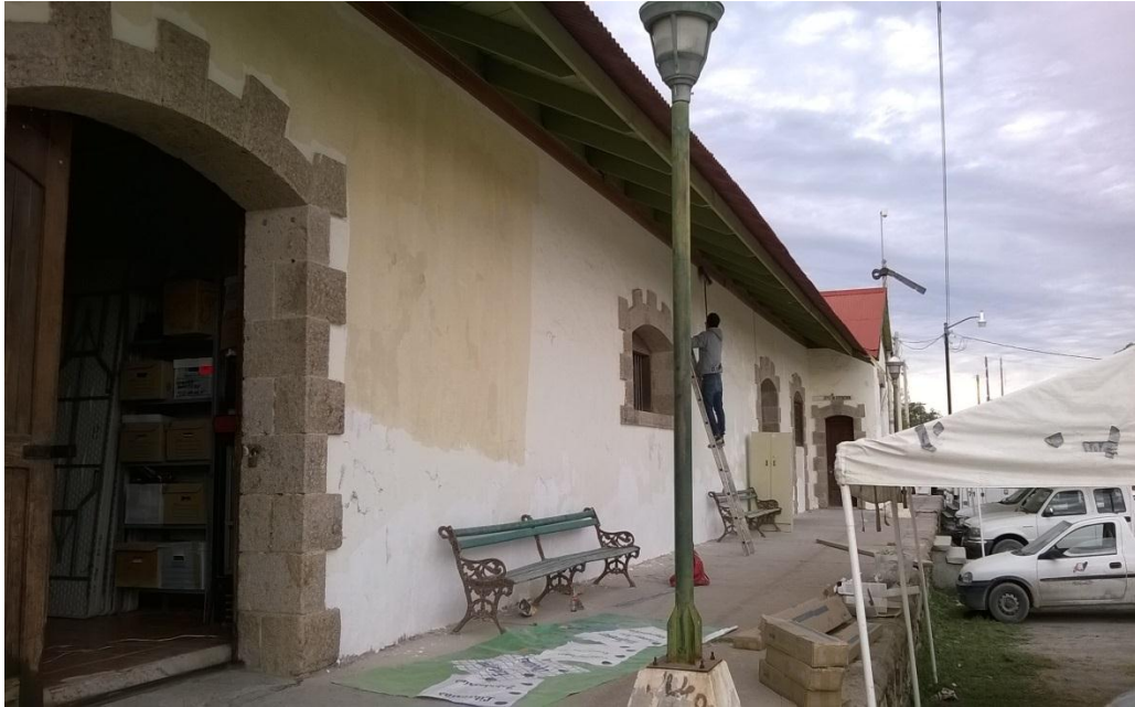
Ilustración 4.- Rehabilitación de oficinas del ramo 33.
